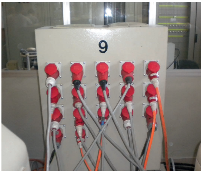
FIGURA 7 Quadro intermedio di sicurezza fra aerotermini e quadri elettrici
